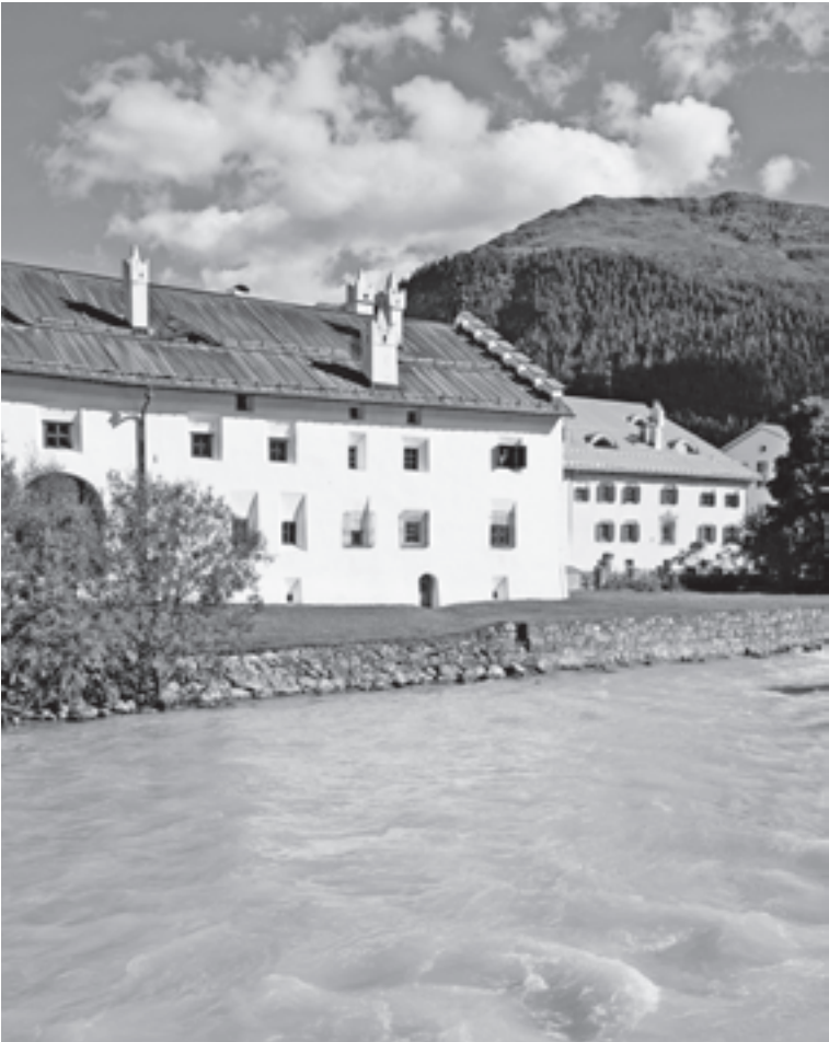
Repräsentative Bürgerhäuser prägen auch heute noch das Erscheinungsbild von La Punt Chamuesch. Foto: swiss-image.ch/Röbi Bösch
